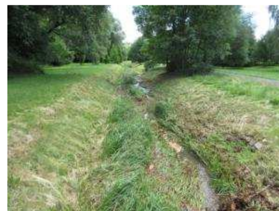
Pohled od propustku dolů
