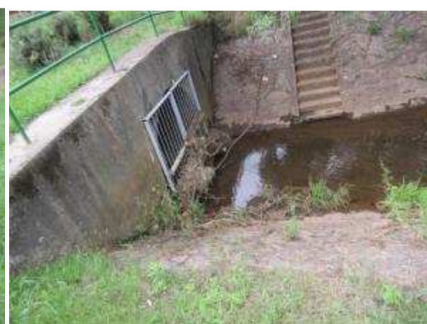
Upravené koryto před vtokem do zatrubněné části pod parkem
