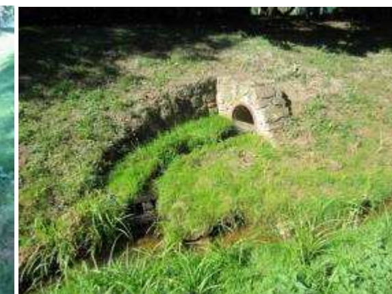
Výúst dešťové kanalizace od Kauflandu
