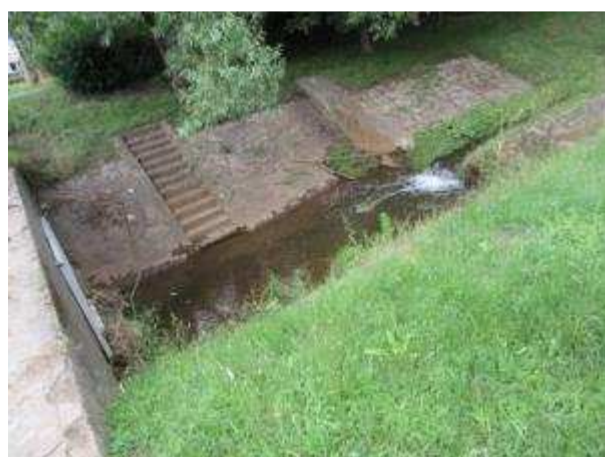
Upravené koryto před vtokem do zatrubněné části pod parkem
