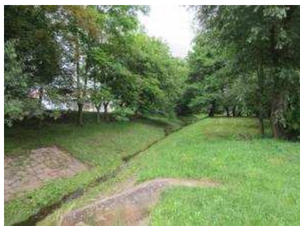
Koryto upraveného potoka
